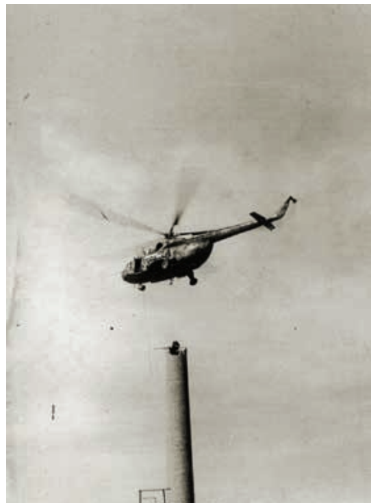
În anii Republicii Populare Române, elicopterele au fost întrebuințate și în economia națională. În imagini, elicoptere Mi-8 folosite pentru montarea unor stâlpi de înaltă tensiune în teren muntos (sus) și pentru construcția coșului de fum al unei termocentrale (jos)
