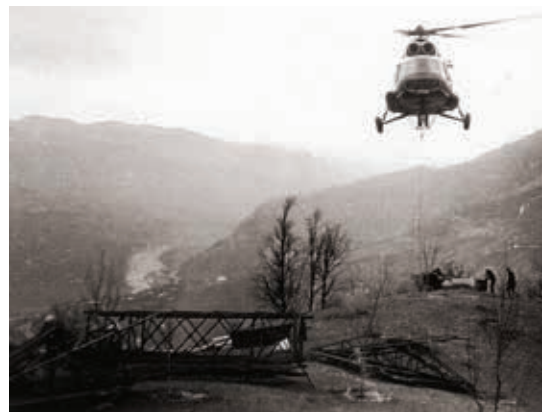
În anii Republicii Populare Române, elicopterele au fost întrebuințate și în economia națională. În imagini, elicoptere Mi-8 folosite pentru montarea unor stâlpi de înaltă tensiune în teren muntos (sus) și pentru construcția coșului de fum al unei termocentrale (jos)
