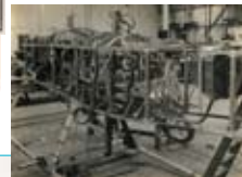
Monoplanul bloc militar, în faza de construcție
