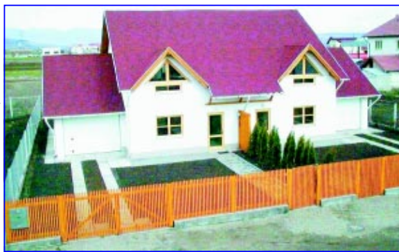
Model funcțional construit la Alba Iulia de firma SPEEDWALL - 2000. Arhitect Ioan Strejan
